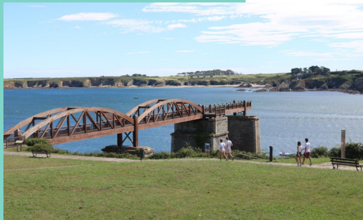
Antigo cargadoiro de mineral no Porto Estreito. O mineral era transportado por ferrocarril a través dunha liña ferroviaria duns 32 km de longo, que a comezos do século XX conectaba Ribadeo cos fornos da zona mineira de Vilaodríz, na Pontenova.
